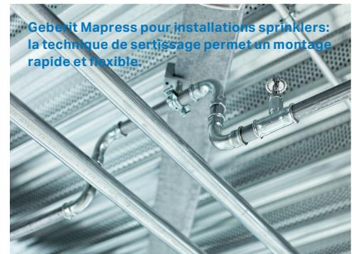
Geberit Mapress pour installations sprinklers: la technique de sertissage permet un montage rapide et flexible.
